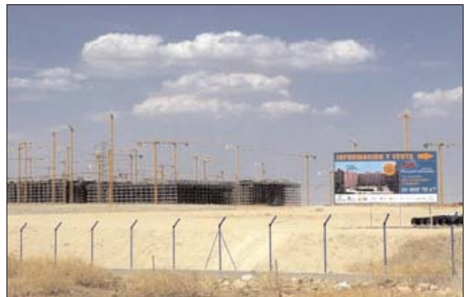
Urbanització illegal en Seseña.
